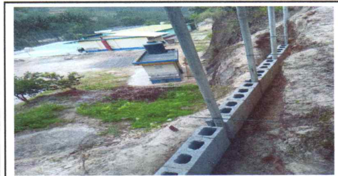
Foto 5: Muro perimetral en proceso de sustitución
