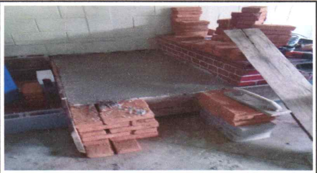
Foto 2: Estufa rural en proceso de restauración
