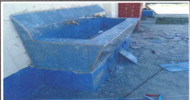
Foto 6: Instalando Azulejo en lavamanos multifuncional
