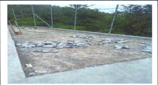
Foto 4: En proceso de sustitución de torta de concreto
